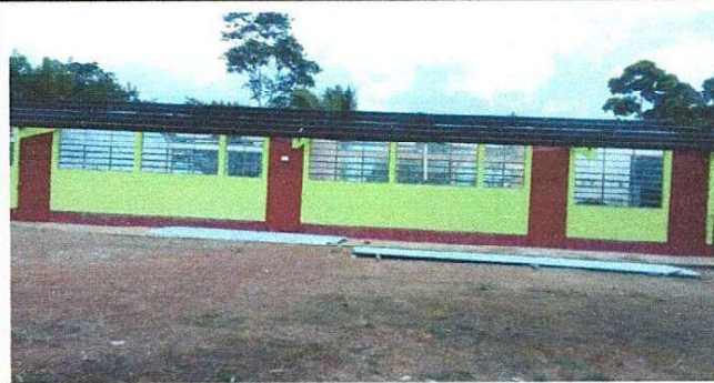
Foto 2: fotografia durante el mantenimiento de las costaneras, de la escuela.
